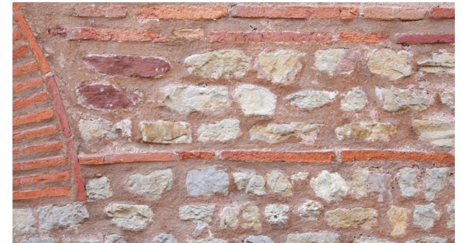
Mauer des Trierer Doms mit Kalksteinen zwischen Ziegeln (sowie zwei Buntsandsteinen)
