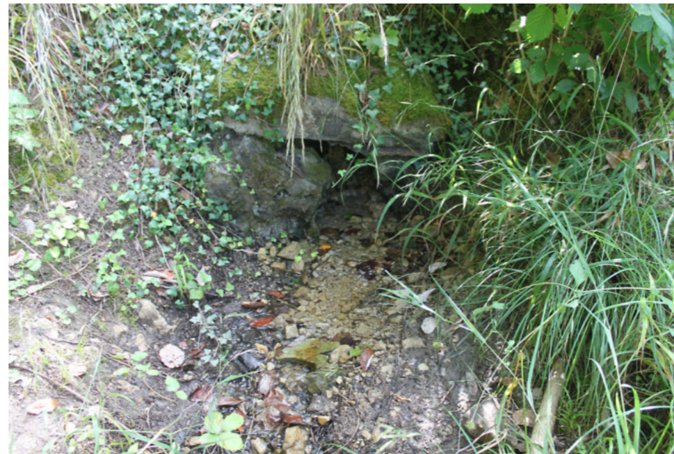
Abfluss des Halbersbornsammelbeckens
