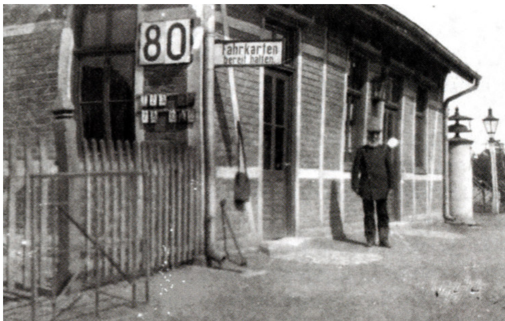
Dienstgebäude des Haltepunktes Wasserliesch
